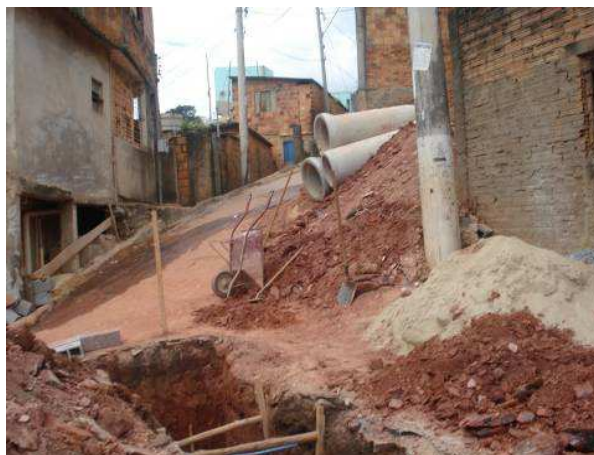
Figura 3: Implantação de rede de esgotamento sanitário. Vila Nossa Senhora de Fátima – 07/2008. Fonte: Arquivo pessoal da autora.
