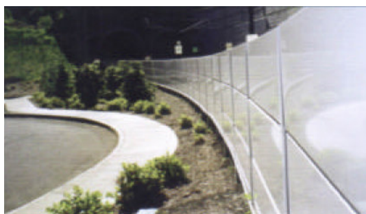
Figura 4 - Barreira acústica metálica 1 Fonte: SOMAX, 2006
