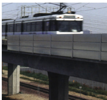
Figura 9 – Barreira instalada em um trecho específico Fonte: SOMAX, 2006
