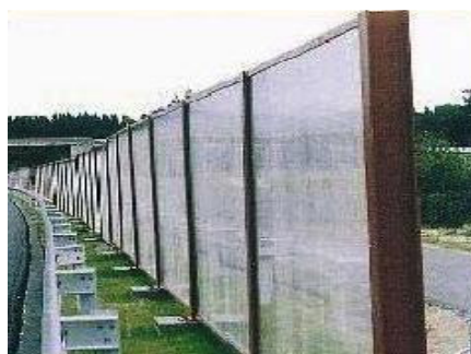
Figura 5 - Barreira acústica de acrílico transparente Fonte: PAZOS, 2004
