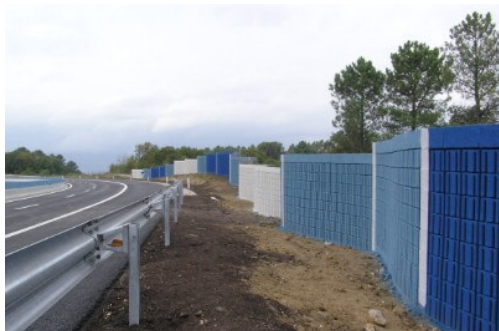
Figura 6 - Barreira acústica de elemento pré-fabricado de betão leve com aplicação ondulada
